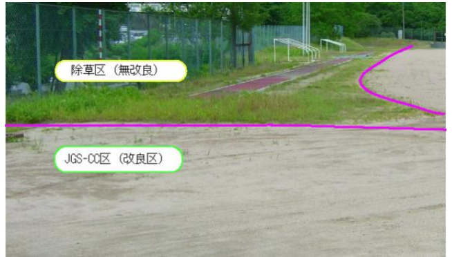
雑草抑制効果比較事例: 施工後約1年
