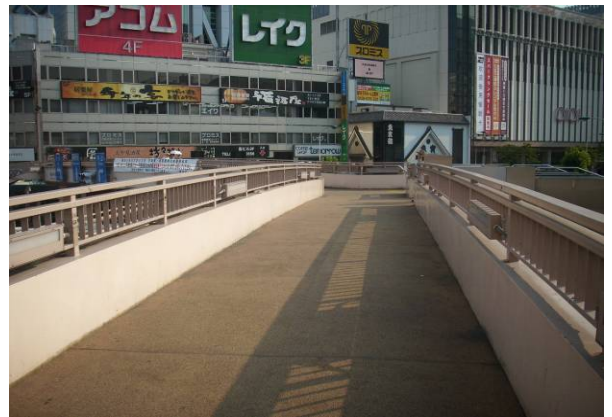
歩道橋歩行部地覆(未塗装/6年経過)
