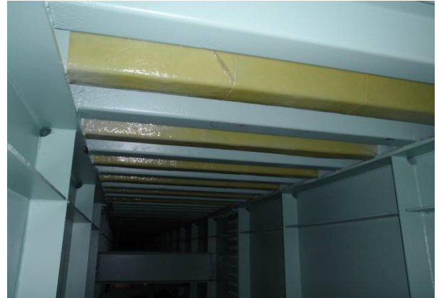
橋梁側道橋デッキプレート(未塗装/施工後)
