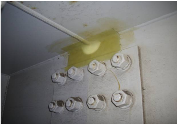
橋梁箱桁スカーラップ(未塗装/施工後)
