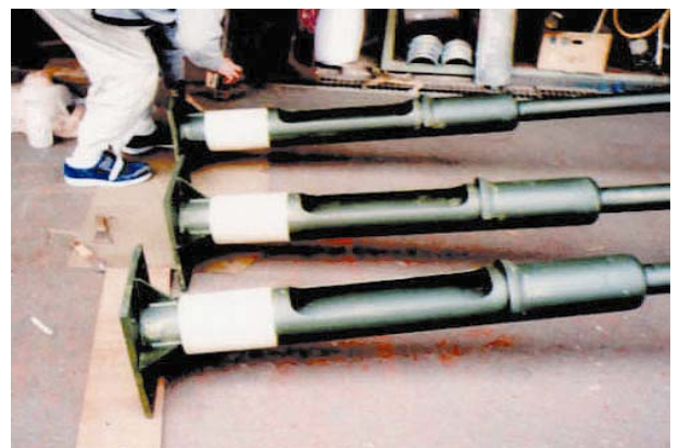
新設照明・標識柱(未塗装/施工後)
