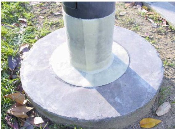
既設照明・標識柱(未塗装/施工後)
