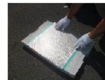
③ガラス連続繊維シート貼付け含浸
