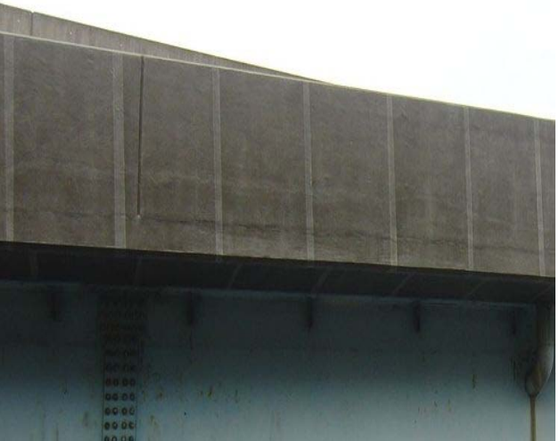
②舞浜大橋 (施工5ヵ月後)
