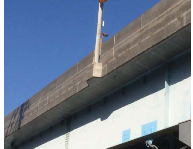
②舞浜大橋 (施工1年9ヶ月後)
