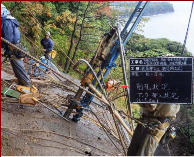
二重管施工／東伊豆町役場発注工事
