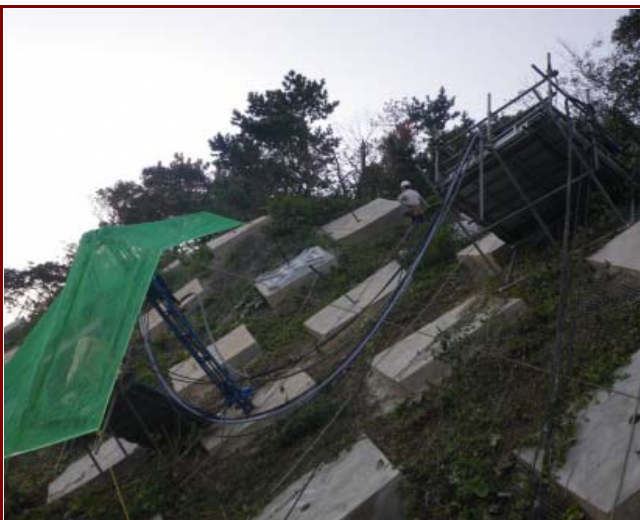
グラウンドアンカー工／下田土木事務所発注工事
