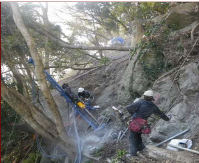
高所樹間施工(1)／賀茂農林事務所発注工事
