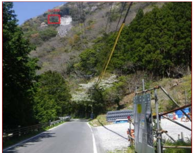
高所樹間施工(2)／賀茂農林事務所発注工事
