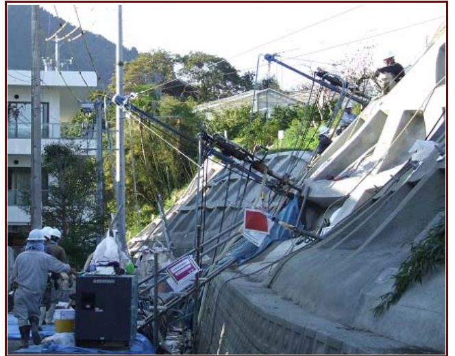
狭小地・複数台施工／静岡市建設部発注工事
