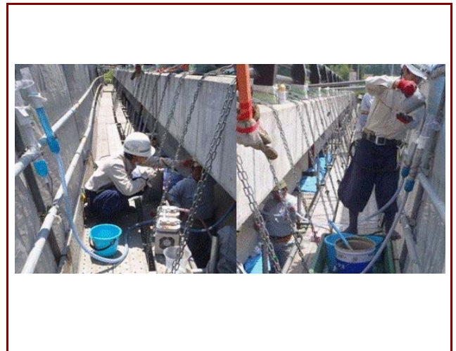
施工状況 (左:水溶液注入 右:補修材充てん)
