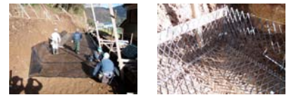
9~13. 盛土材まき出し、転圧、ジオグリッド巻き上げ、裏込め土転圧
