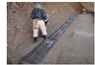
9~13. 盛土材まき出し、転圧、ジオグリッド巻き上げ、裏込め土転圧
