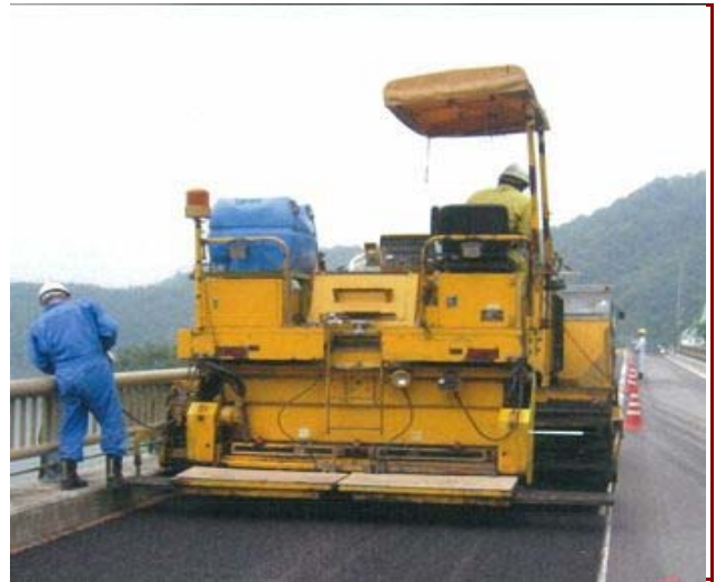
施工状況 (専用フィニッシャ使用)
