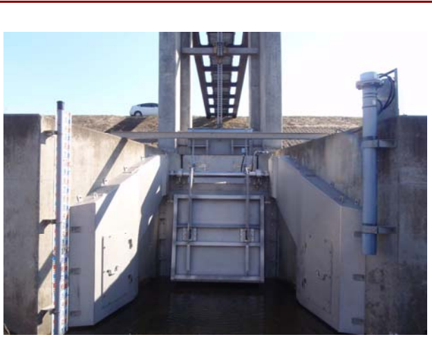
石狩川上流・天塩川上流樋門
