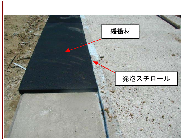
基礎部施工写真
