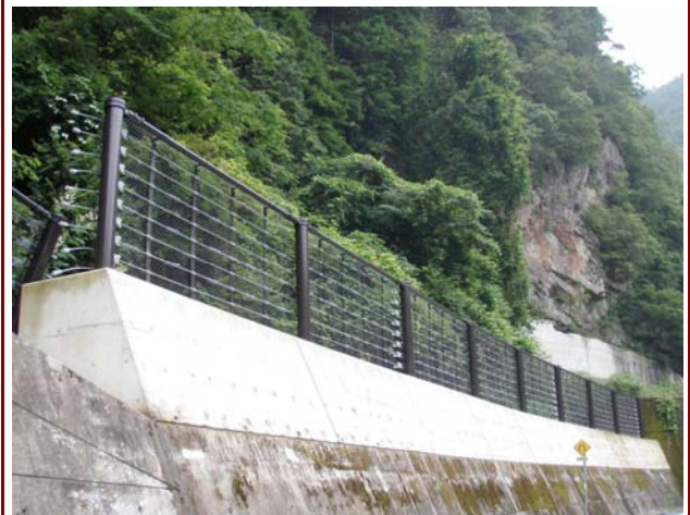
完成写真(着色・擁壁仕様)
