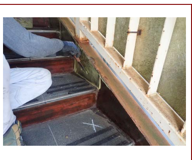
シート脱泡状況
