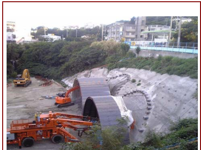
パイプルーフ完了後トンネル坑口掘削前
