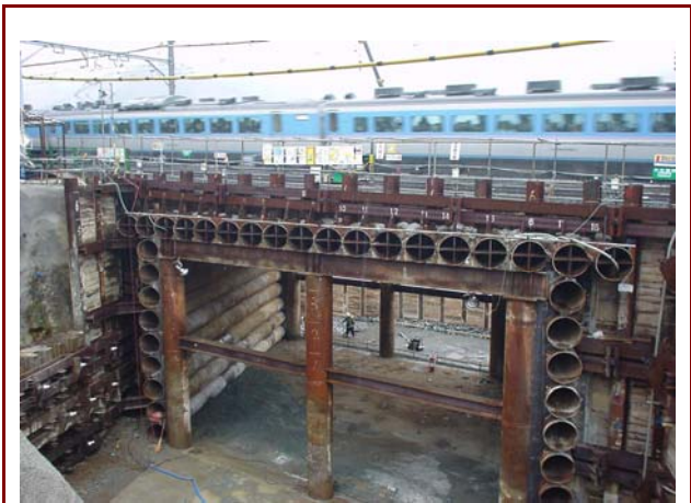
鉄道線路下パイプルーフ施工完了状況
