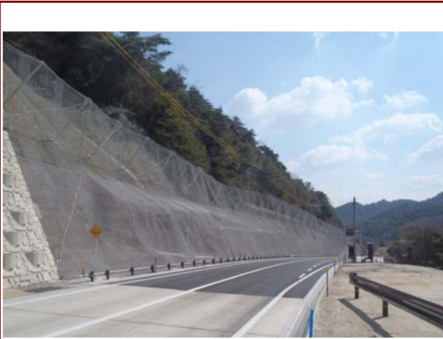
施工事例-1 (ポケット式ネットワン)
