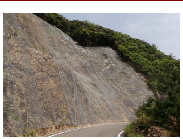
施工事例-2 (覆い式ネットワン)
