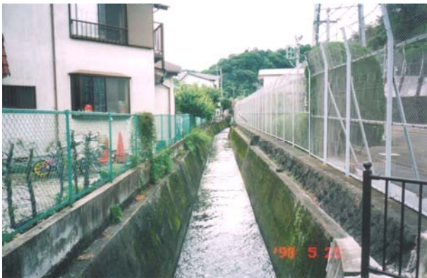
静岡県伊東市 施工前
