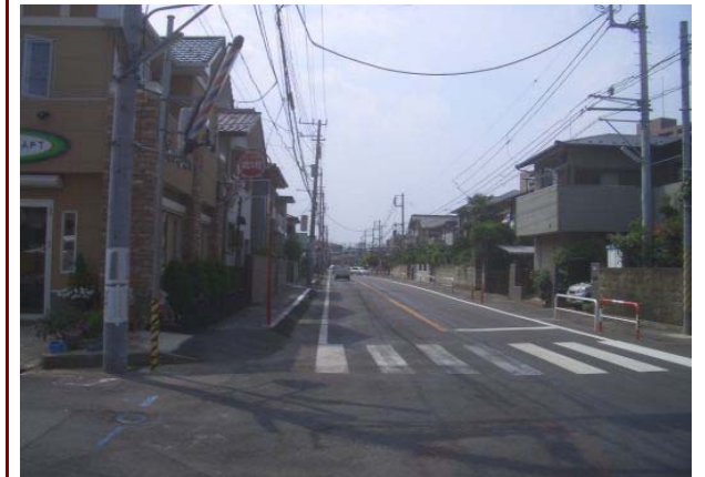
千葉県我孫子市 施工後
