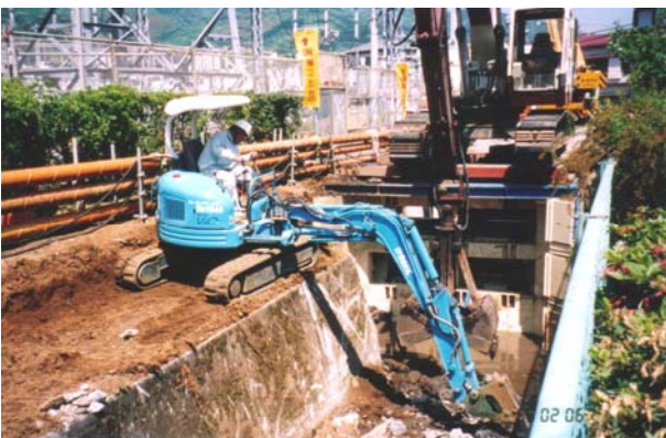
静岡県伊東市 施工状況
