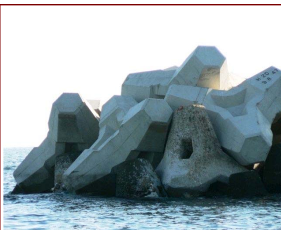
据付完成状況-2
