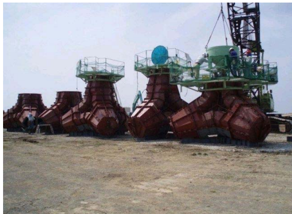
コンクリート打設状況
