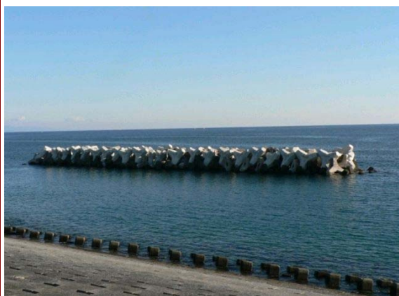
据付完成状況-1
