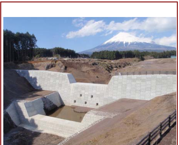
下流側外部保護材設置状況
