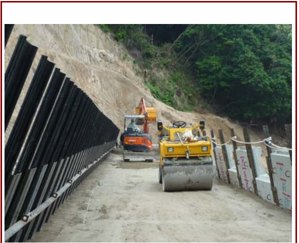
INSEM材の敷均し、締固め状況
