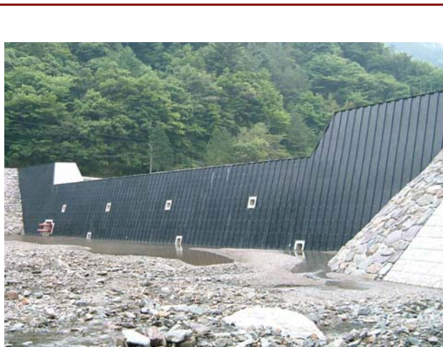
上流側外部保護材設置状況
