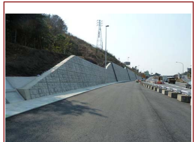
完成写真(1号磐田BP加茂地区道路建設工事)
