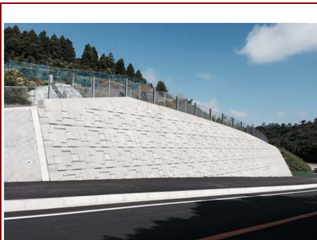
完成写真(伊東135号交差点改良工事)
