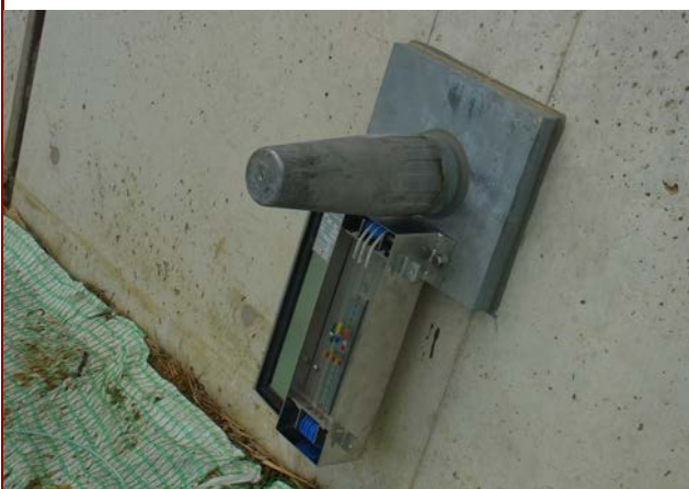
施工事例③
