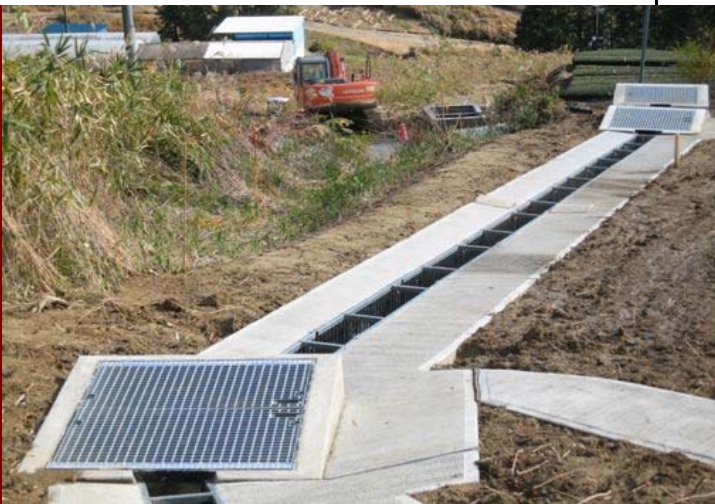
施工事例 (静岡県中遠農林事務所)
