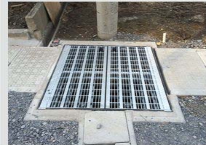
施工事例 (岩手県久慈市役所)
