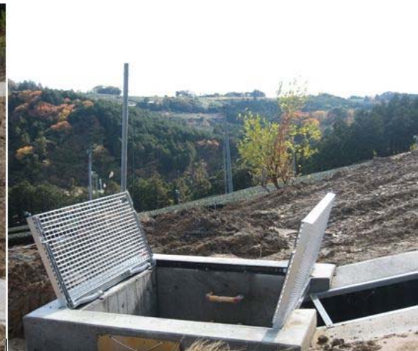
平成25年度 地すべり対策御林地区排水路1工事
