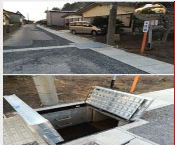
避難道路大崎本通線道路改良舗装工事
