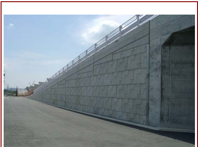
【NEXCO】第二東名高速道路 浜北高架橋
