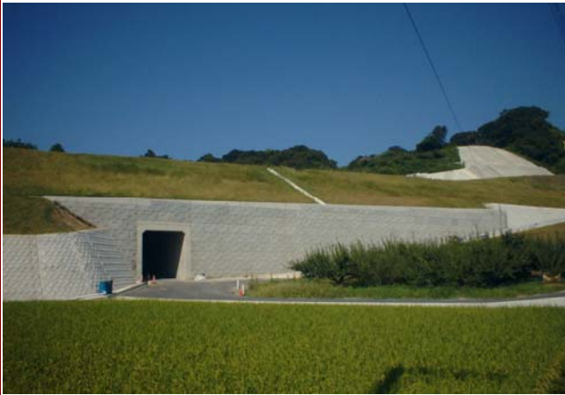
【NEXCO】阪和自動車道 芳養工事
