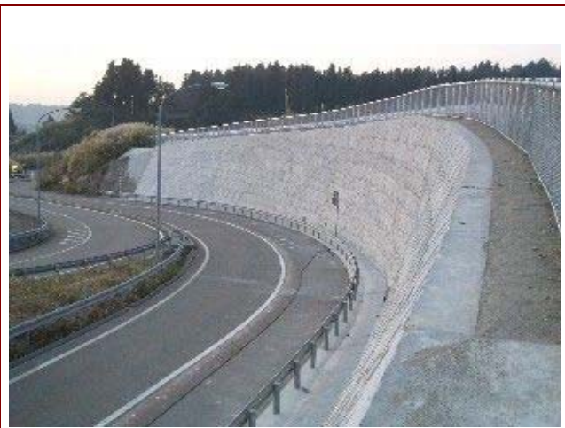
【NEXCO】関越自動車道魚沼地区災害復旧工事
