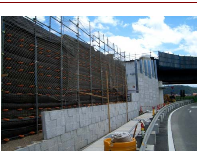
【国交省】益田道路飯田 第2改良工事
