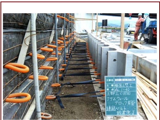
【国交省】益田道路 飯田第2改良工事
