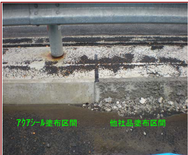
凍結劣化抑制効果 (国道地覆部)
