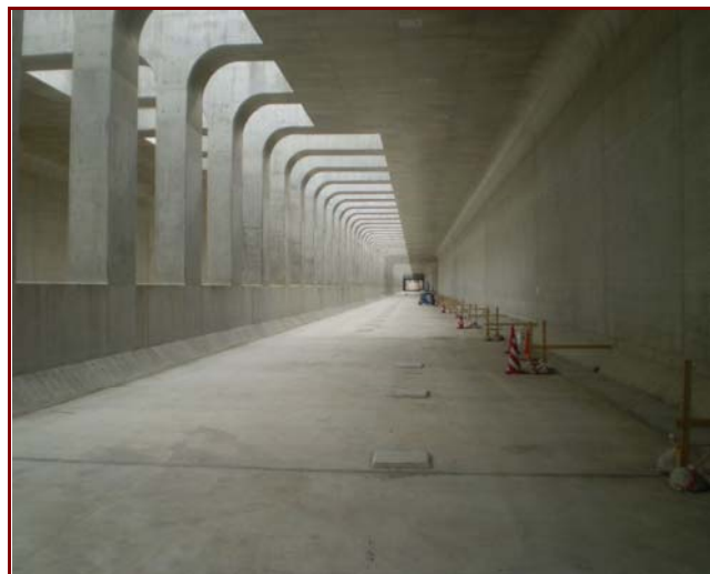
施工実績 自動車道剥落対策工
