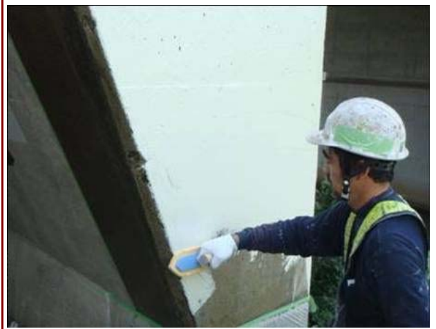
施工状況:レジガードボンドSD
