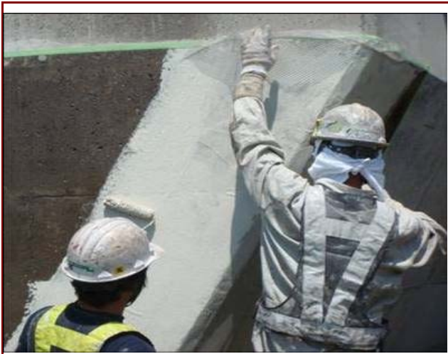
施工状況:シート貼付
