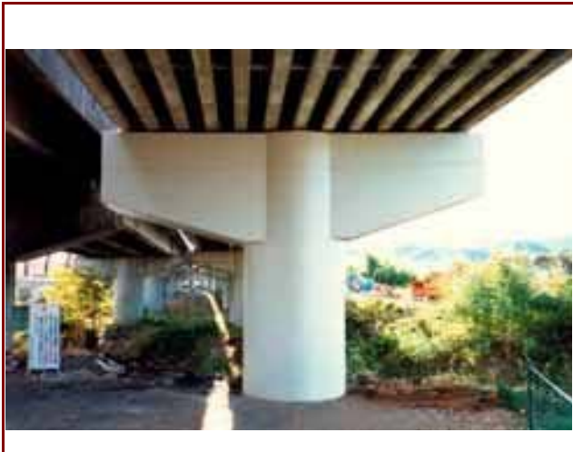
レジガードSD工法使用後
