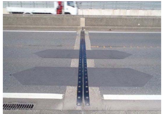
施工後(橋梁ジョイントの段差補修)
