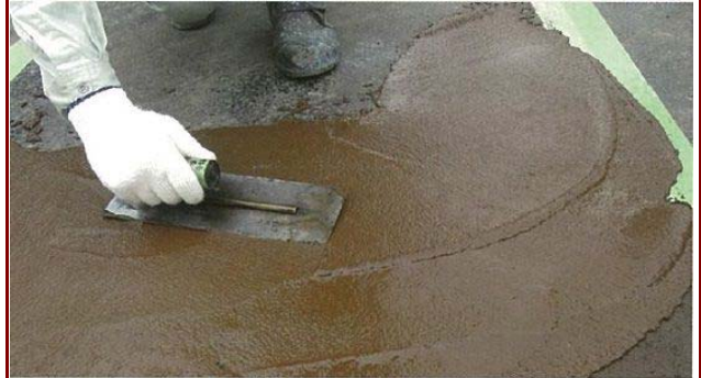
施工の様子(コテ仕上げ)
