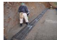
9～13. 盛土材まき出し、転圧、ジオグリッド巻き上げ、裏込め土転圧
