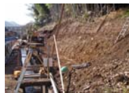
9～13. 盛土材まき出し、転圧、ジオグリッド巻き上げ、裏込め土転圧
