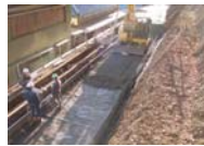
9～13. 盛土材まき出し、転圧、ジオグリッド巻き上げ、裏込め土転圧
