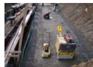
9～13. 盛土材まき出し、転圧、ジオグリッド巻き上げ、裏込め土転圧
