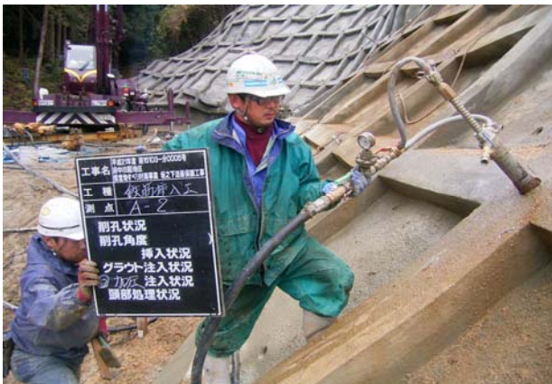
2方向加圧注入の状況
