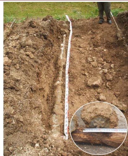
2方向加圧注入後の掘り起こり状況
