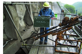
小型ボーリングマシン(空気式)
