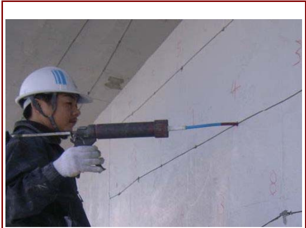
バックフィル材注入状況
