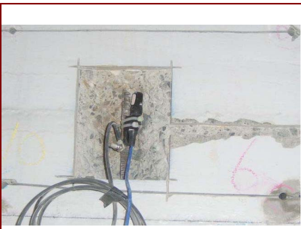
陰極・照合電極設置状況
