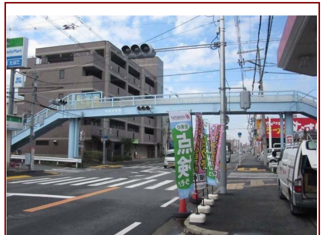
主要地方道大阪東大阪線池島歩道橋塗装塗替工事その2
