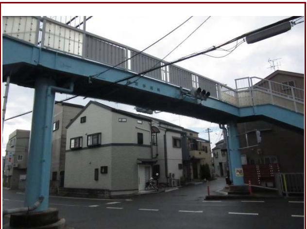
一般府道石切大阪線北宮歩道橋橋梁塗替工事
