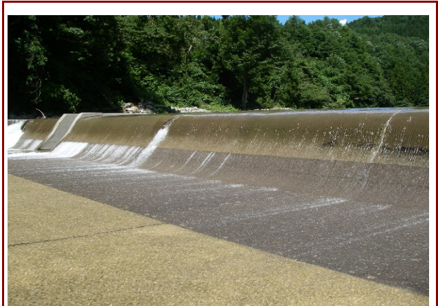
設置例:エプロン補修(供用開始)
