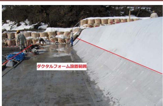
設置例:エプロン補修(納入)
