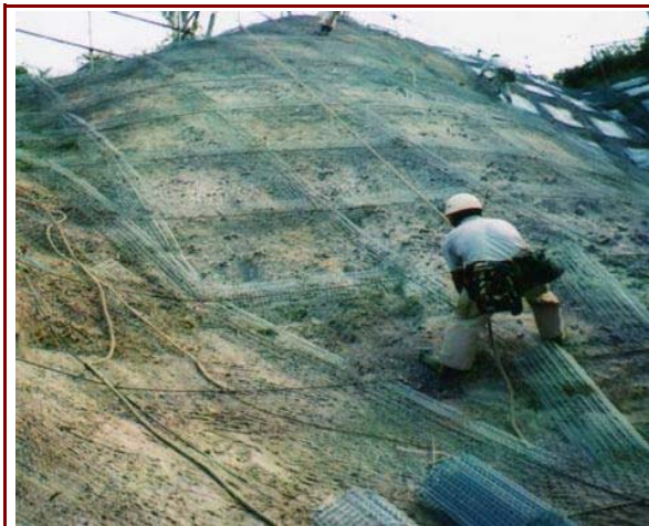
成形用部材の設置
