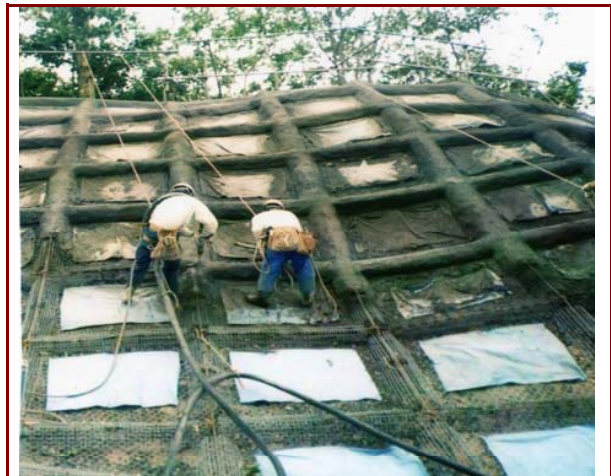
モルタル吹付作業中
