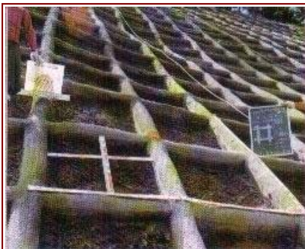
枠内清掃完了 出来形検査
