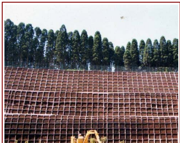
枠内緑化基材吹付工完了
