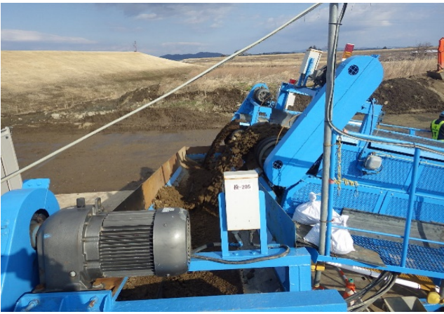
投入コンベア(万能土質改良機への投入)
