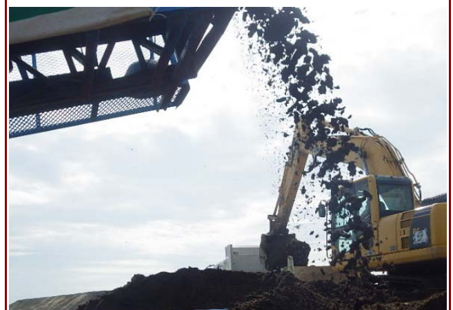
混合処理土の排出
