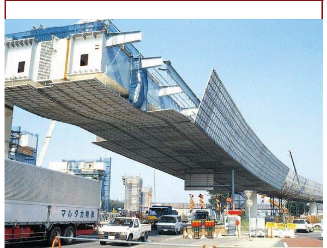
セーフティSKパネル設置外観
