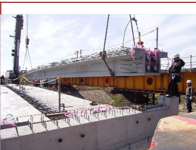
主桁架設(現場施工)
