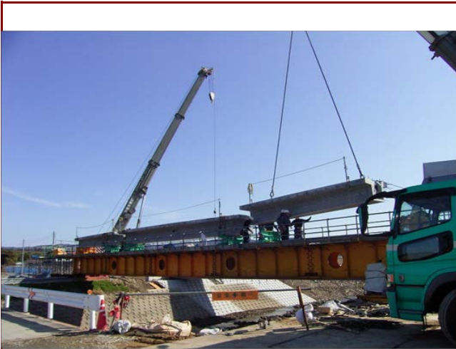
セグメント運搬・組立準備(現場施工)
