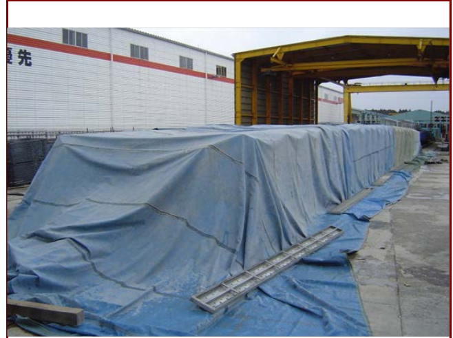
蒸気養生状況(工場製作)
