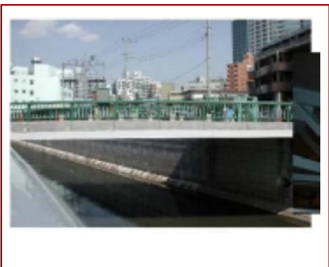
施工実績 豊水橋
