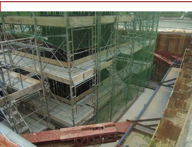
橋脚足場設置状況
