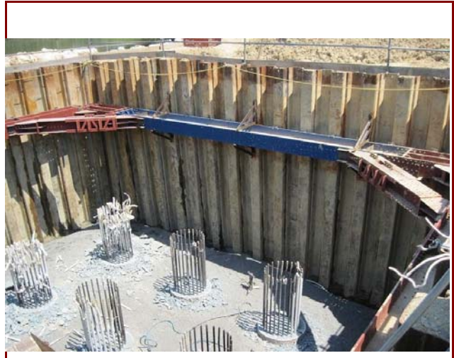
基礎杭頭部処理後
