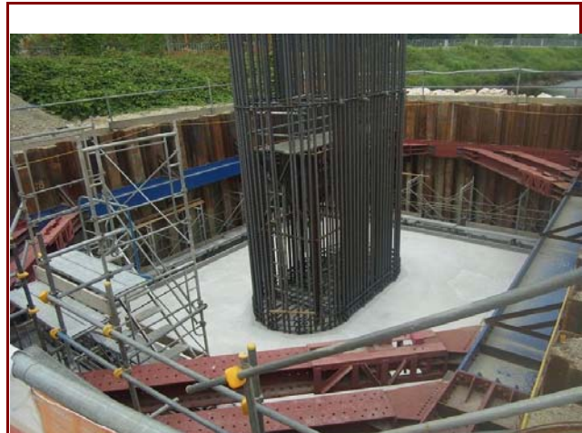
橋脚基礎コンクリート打設後
