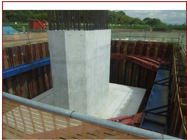
橋脚基礎コンクリート打設後
