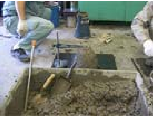
スランプ試験状況
