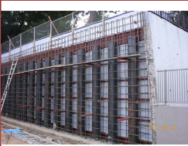
杭突出部と現場打ちコンクリートの配筋
