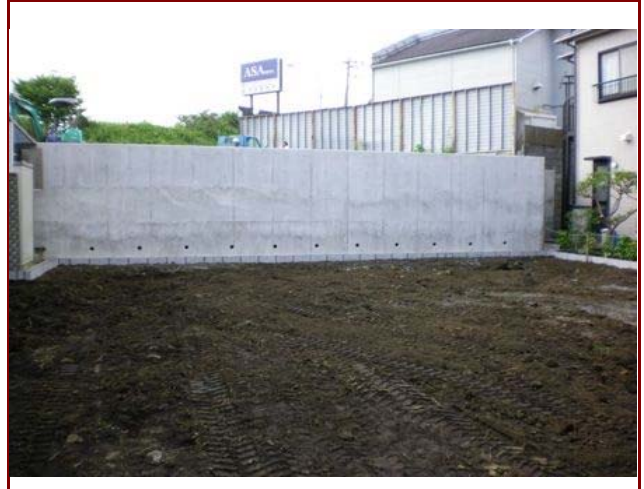
事例1: 宅地造成 (施工後)
