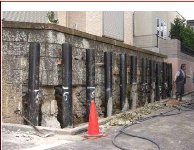
※既設の擁壁を利用(存置)した擁壁補強 事例2: 既存擁壁補修 (杭施工時)
