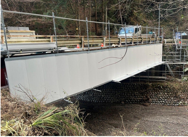
TOBISLIDE 防護柵(朝顔)施工
