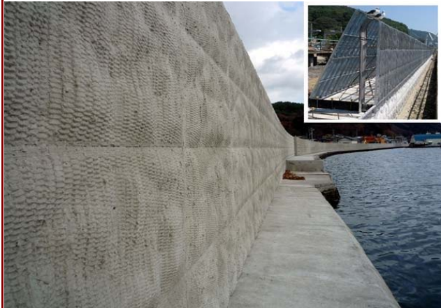
擁壁工での施工事例
