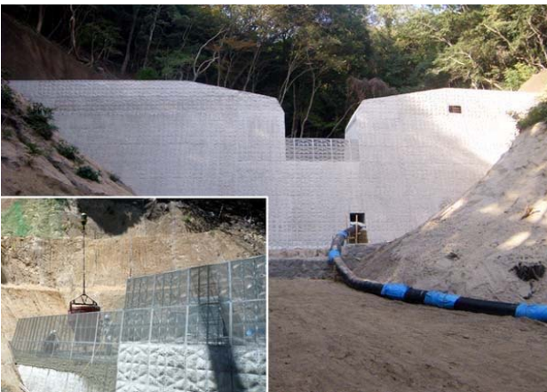
砂防堰堤での施工事例
