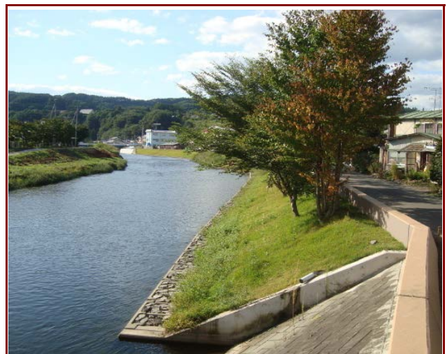
施工事例(青森県 熊原川)
