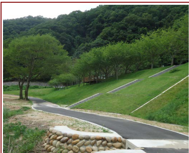
施工事例(京都府 木津川)
