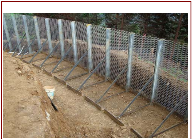
支柱材等組立て(全景)
