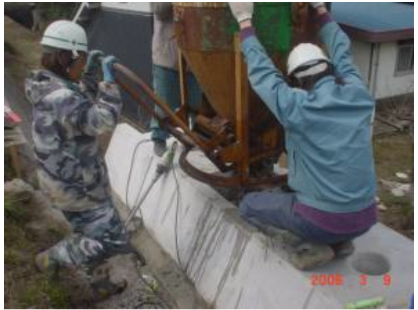
生コン打設状況
