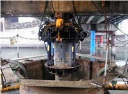
圧入装置設置
