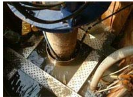
高圧ジェットによる洗浄
