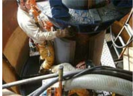
補強鋼板設置
