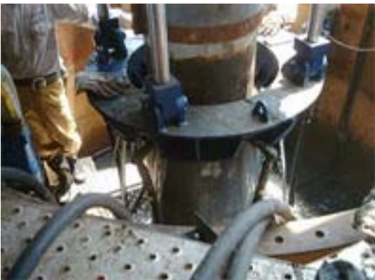
補強鋼板圧入
