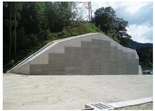
コンクリート擁壁美観維持・落書き対策
