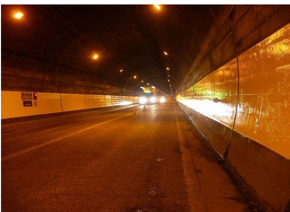
トンネル内装塗装状況後
