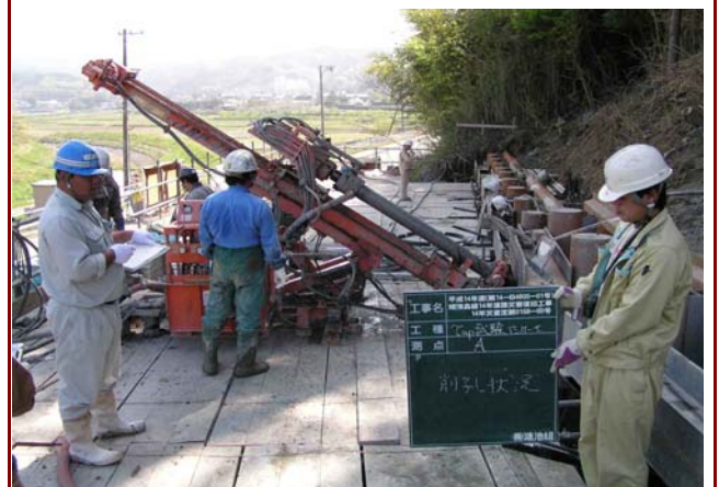
タウアップビットによる施工状況
