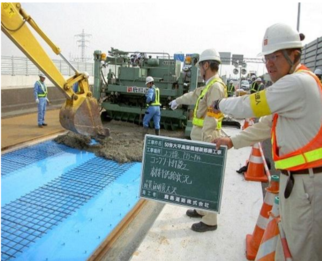
SFRC打設状況
