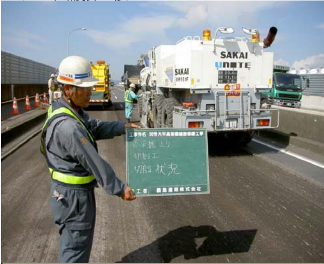
舗装版撤去工
