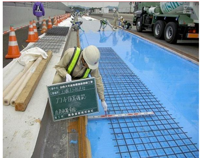
グリッド筋設置工
