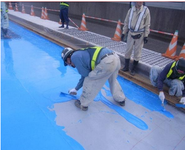
KSボンド塗布工
