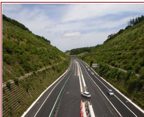
道路法面(施工後5年)
