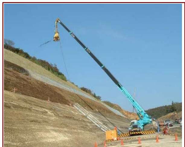
生育基盤造成状況(クレーン)
