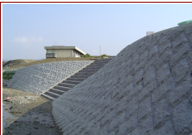
布留川河川改良工事
