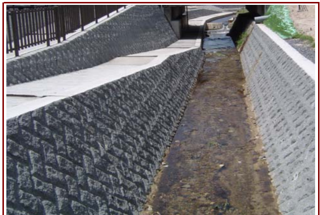
天端部の切断処理
