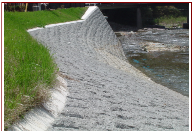
丹生川河川改良工事
