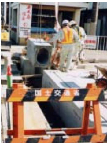
1号弁天島駅前施工
