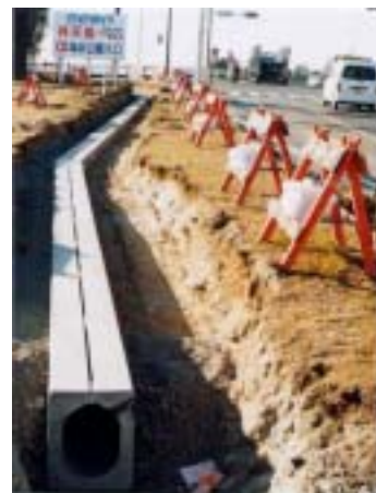
1号弁天島駅前施工
