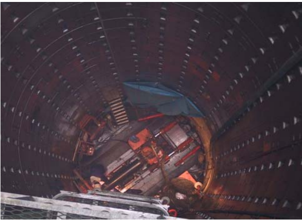
集水井内における施工状況
