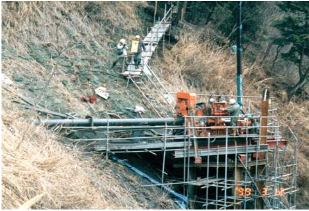
地表面における施工状況
