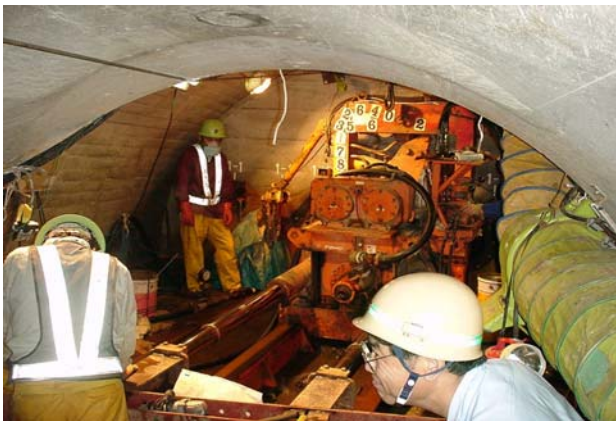
排水トンネルボーリング室での施工状況
