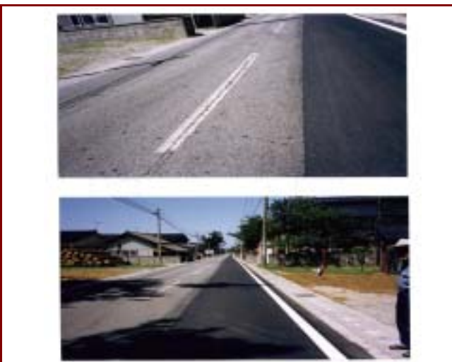
施工実績平成14年施工
